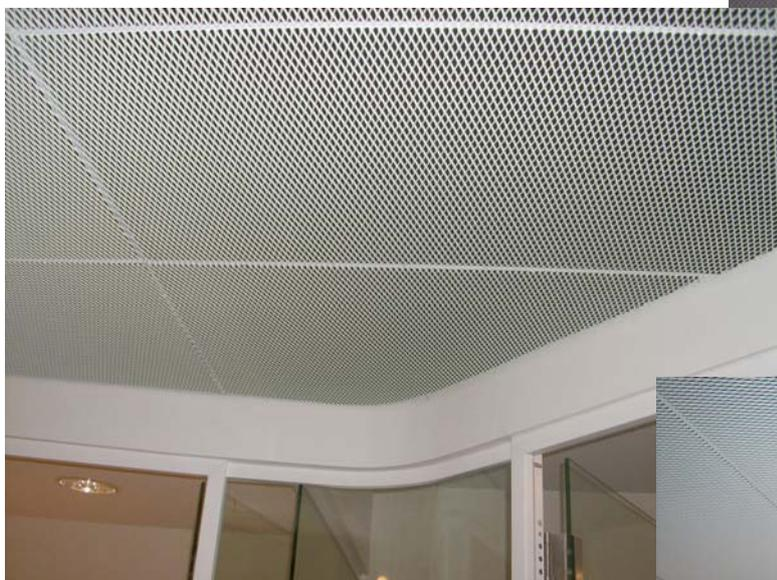
Einbauten, wie in Foto unten ersichtlich sind jederzeit möglich. Wir empfehlen einen aufgeschweißten Verstärkungsring auf den Ausschnitt (Seite Richtung Deckenhohlraum), für einen besseren und vor allem bündigeren Einbau der Einbauten.
