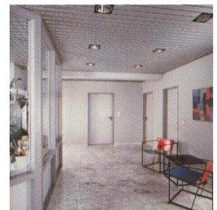
Die Standardpaneeldecke ME-Paneel10 mit offener Fuge wird aus 0,5mm starken Aluminium gefertigt. Im geschützten Außenbereich oder im Feuchtraumbereich wird die Unterkonstruktion zusätzlich mit einem geprüften Korrosionsschutz (Schutzklasse III) versehen. Die Paneeldecke gibt es im Modul 100, 150 und 200mm mit 16mm offener Fuge.
